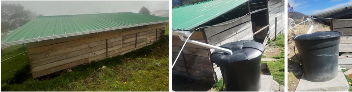
Ilustración 12. Sistema de captación de aguas lluvias, Sede Betania
