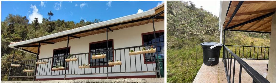
Ilustración 13. Sistema captación de aguas lluvias, Sede San Juan
