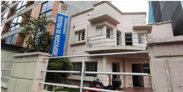
Fotografía 3 Fachada del edificio.
